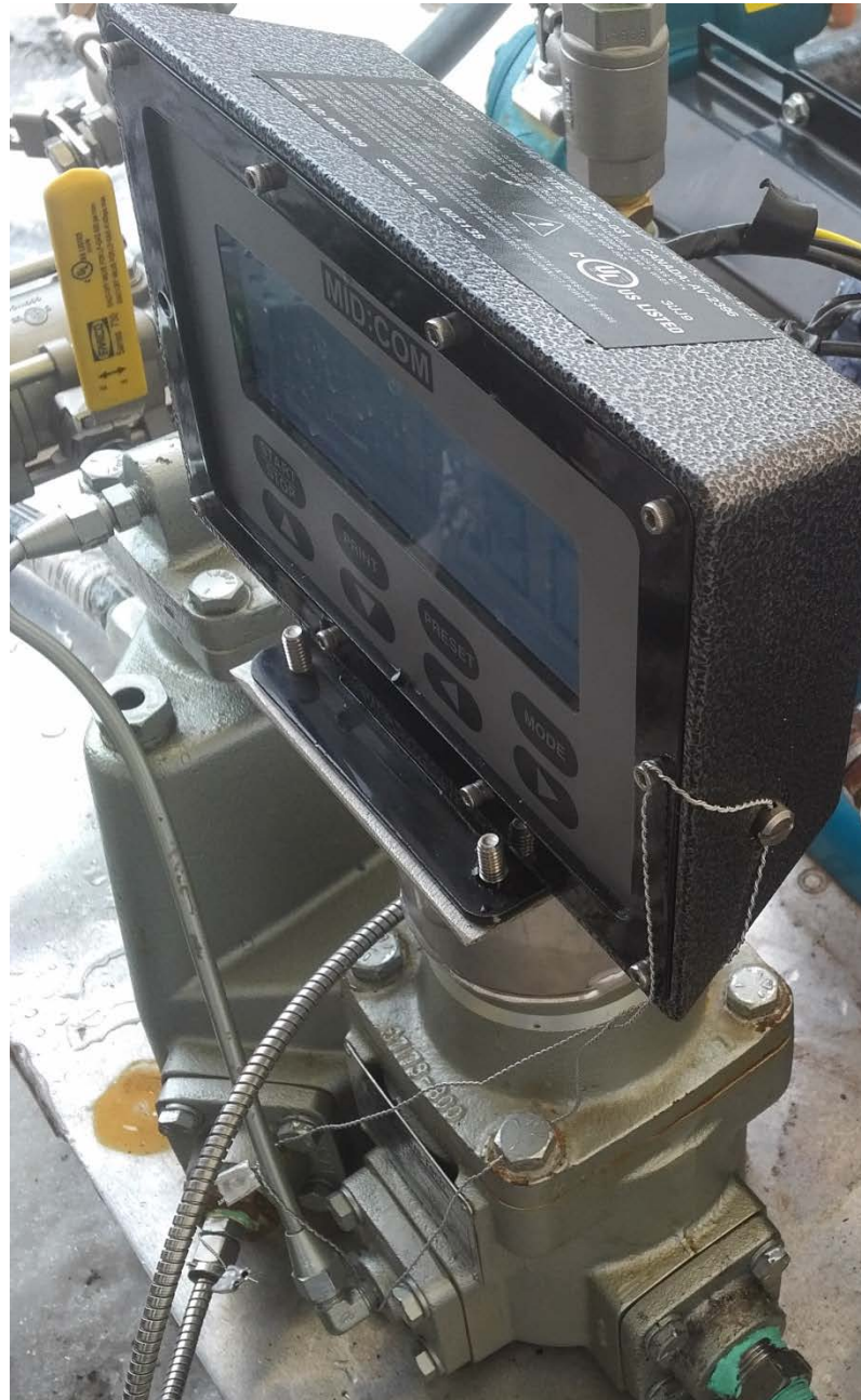
Figure 2: LPM-102 meter sealed with the MID:COM electronic register / Compteur LPM-102 scellé avec l'enregistreur électronique MID:COM
