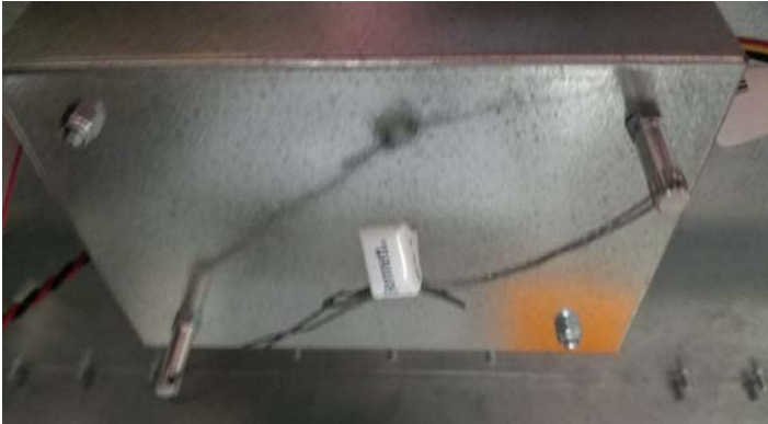
Figure 3 Sealing the I/O 419 board metallic cover under the bezel | Scellage de la couverture métallique de la carte électronique d'E/S 419 sous la boîte d'enregistreur.
