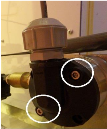
Use of paper seal on meter cover. Utilisation de sceau en papier sur le couvercle du compteur.
