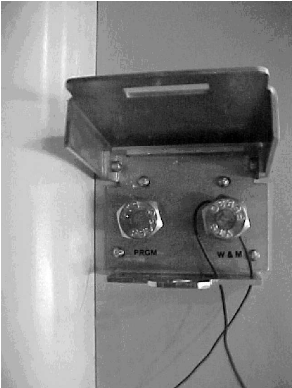
Fig. 8: Security Bolts with magnetic tips (Type 2 Switch) / Boulons en sécurité avec aimant sur l'extrémité (interrupteur de type 2)
