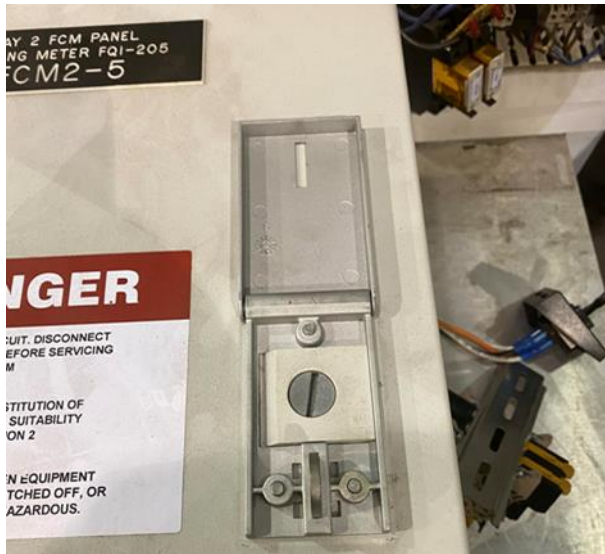
Figure 17: Left: Typical FCM Enclosure with Seal Broken and Latch Open; Right: Typical FCM Enclosure with Seal Broken | Gauche : boîtier FCM typique avec joint brisé et loquet ouvert ; Droite : Boîtier FCM typique avec joint brisé.
