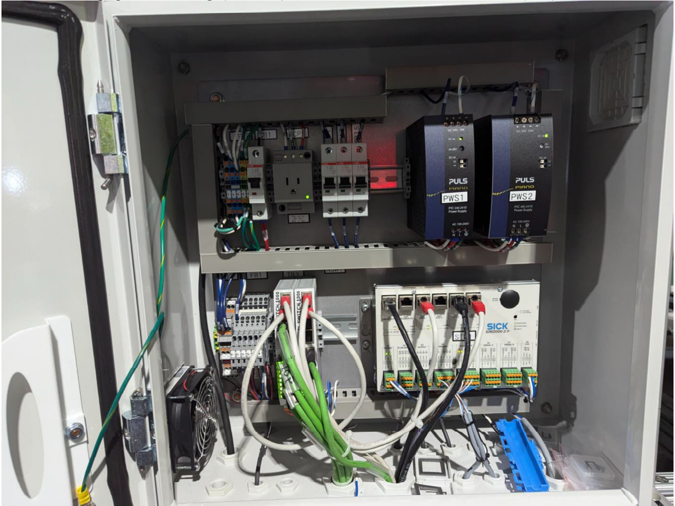
Typical Control Cabinet Layout / Disposition typique d'une armoire de commande
