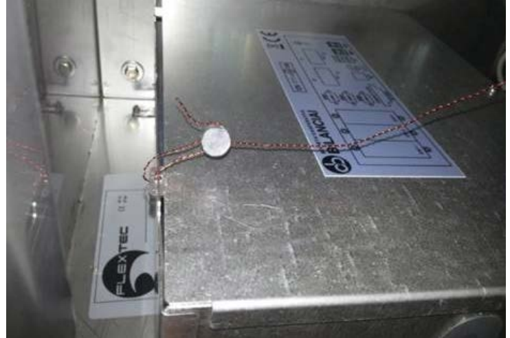
Sealing for model DD 2050 / Scellage du modèle DD 2050
