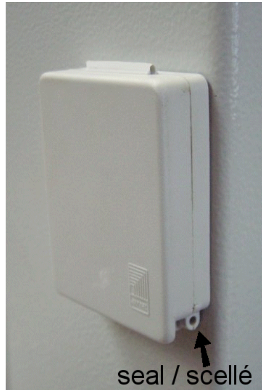
Typical cabinet sealing / Scellage typique du boîtier de l'unité de commande
