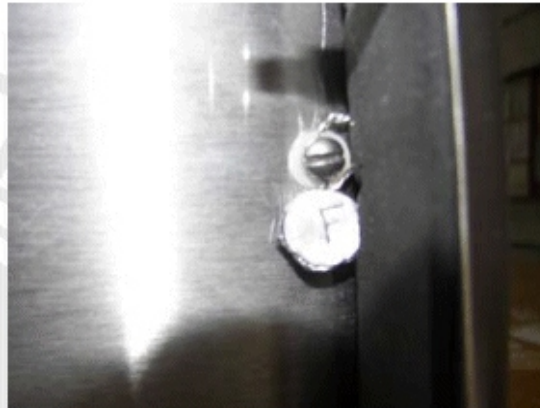
Typical sealing of panel mounted model FB2550-XXX / Scellage typique du modèle FB2550-XXX fixé à un panneau
