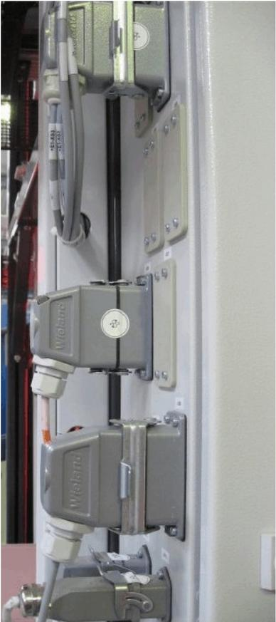
**Computer cabinet connector Sealing / Scellage du connecteur du boîtier de l'ordinateur**
