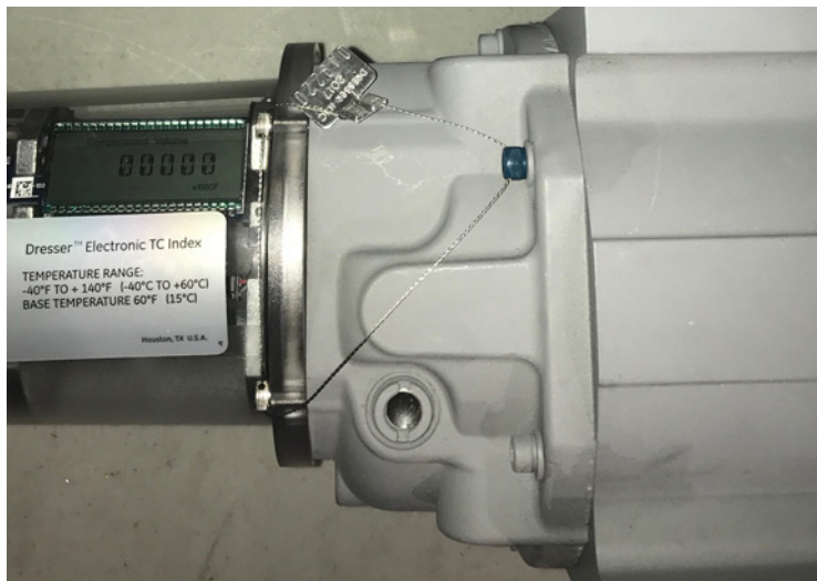
Figure 10. Sealing the Conversion device to Roots series "B" meters \ Scellage du dispositif de conversion au corps du compteur Roots de série « B »
