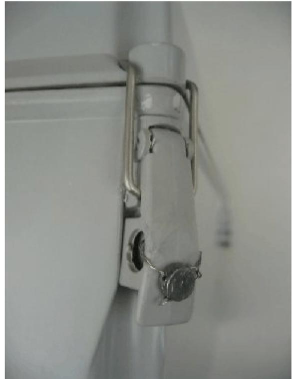
**Figure 3.** Sealing the quick-release latch /Scellage de l'attache à ouverture rapide
