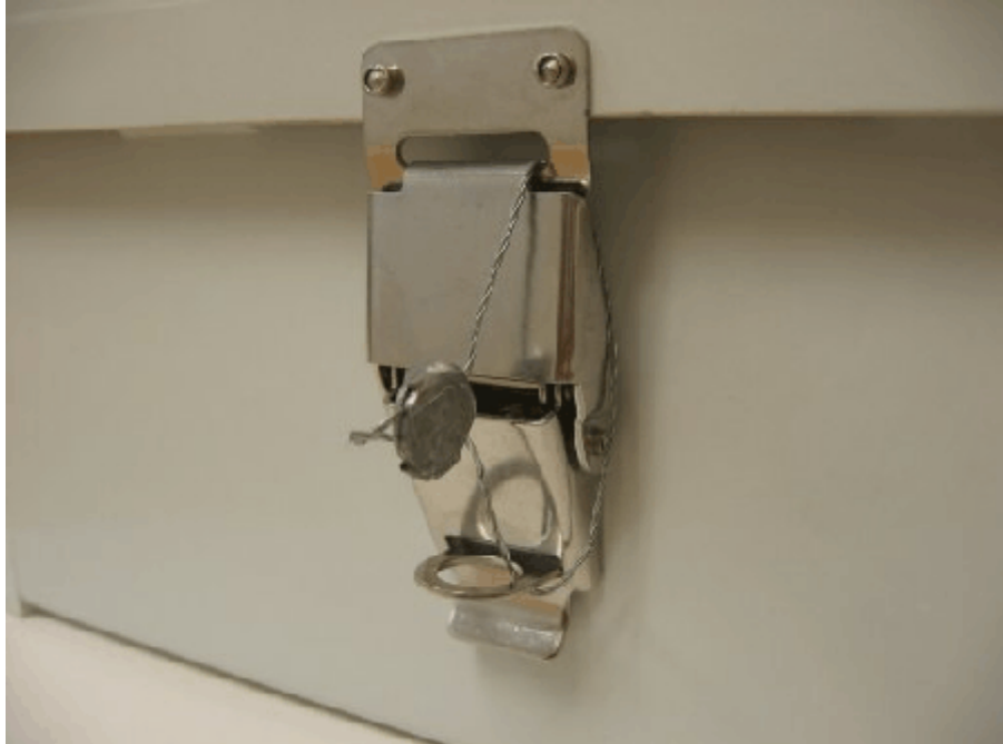
Fig.2 : NEMA 4X Enclosure Sealing / Scellage du Boîtier NEMA 4X
