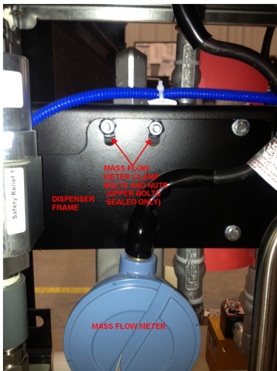
Figure 6. Sealing provision for the mass flow meter for dispensers with a Gilbarco style cabinet / Scellage du débitmètre massique pour les distributeurs avec une enceinte Gilbarco
