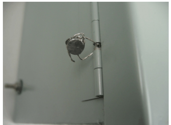
Figure 7. 1141L Hinge Pin Sealing / Scellage de la tige de la charnière du modèle 1141L
