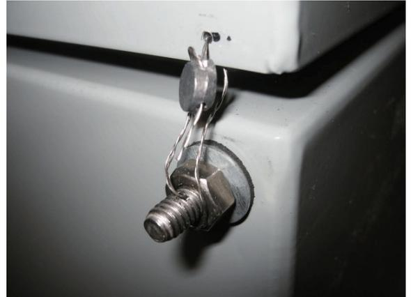
**Figure 9** Sealing provisions for steel enclosure / disposition de scellage pour le boîtier en acier
