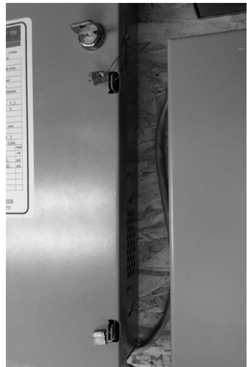
Model T2mA meter with two utility seals / Modèle T2mA avec deux sceaux d'installation
