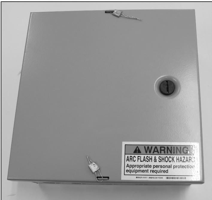
**IO51 PT Box Sealing / Scellage de la boîte TT IO51**
