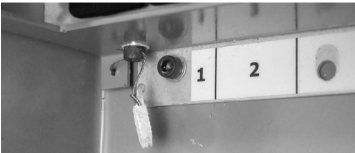
Figure 2: PXMP-SC-S1 verification seal #1 / Premier sceau de vérification sur le PXMP-SC-S1.
