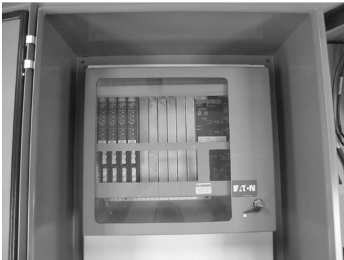
Figure 12: PXMP meter nested inside PXMP-SC-S1, PXMP-SC-S2 and NEMA enclosures / Un compteur PXMP imbriqué dans des boîtiers PXMP-SC-S1, PXMP-SC-S2 et NEMA.
