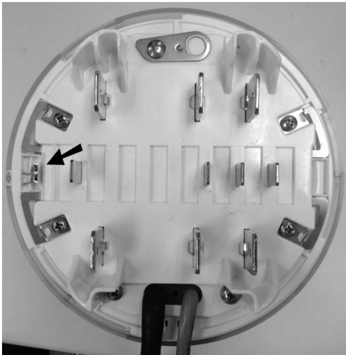
Single seal on a socket type meter / Sceau unique sur un compteur de type socle.
