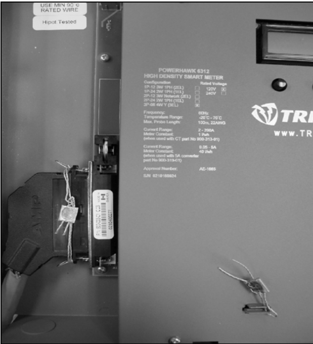
(1) Metrological Sealing Locations / (1) Emplacements des sceaux métrologiques
