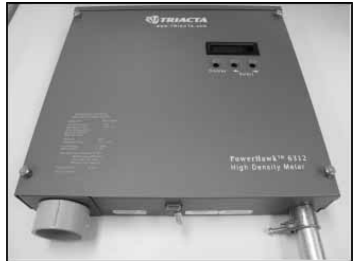
(2) Installation Sealing Location / (2) Emplacement du sceau d'installation
