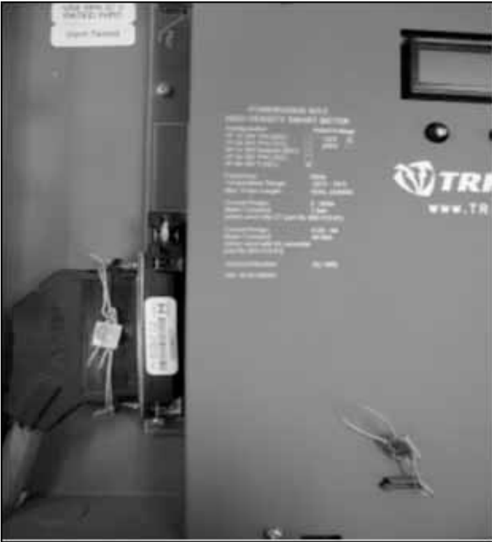
(1) Metrological Sealing Locations / (1) Emplacements des sceaux métrologiques
