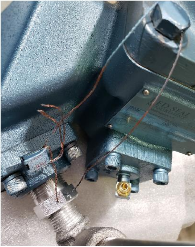
Figure 5: Sealing the ATC probe conduit with the meter | Le scellage du conduit de la sonde CAT avec le compteur
