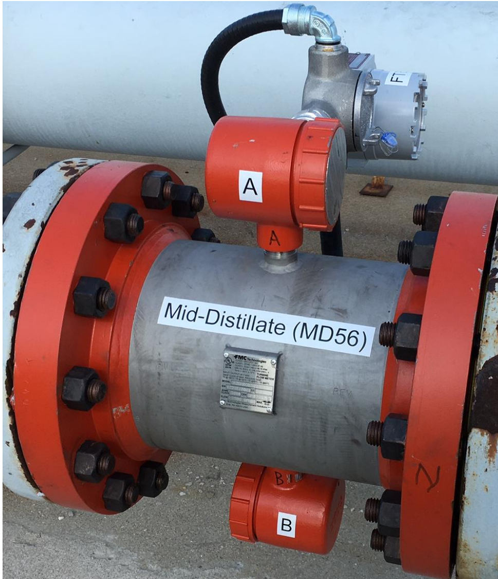
Figure 1: The K2D 8 Inch Sentry Turbine meter with two pickup coils | Le compteur à turbine Sentry K2D de 8 pouces avec bobines de détection
