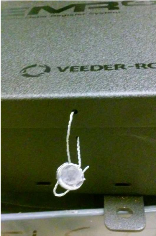
**Figure 5** Interconnect Box sealing/ Scellement du boîtier d'interconnexion
