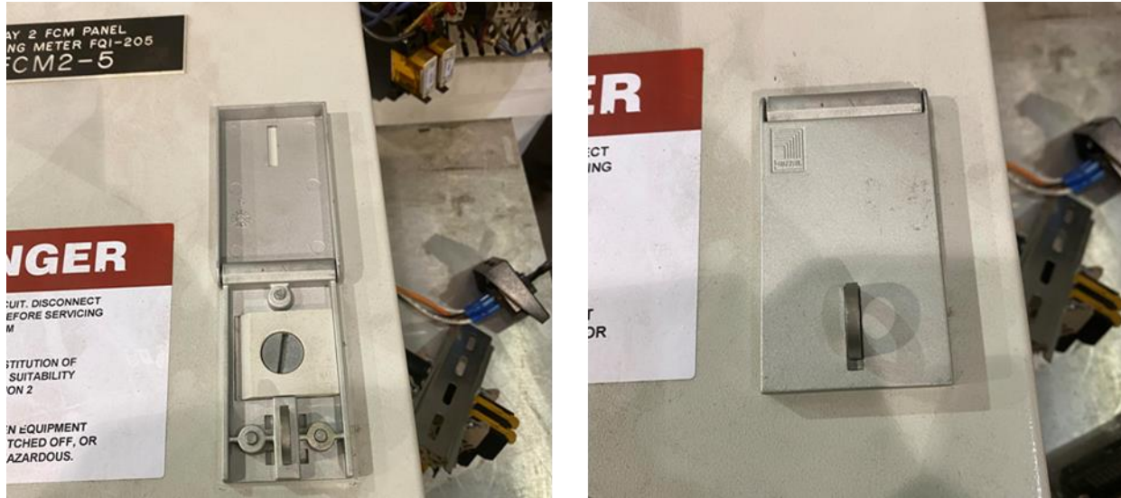
Figure 12: Left: Typical FCM Enclosure with Seal Broken and Latch Open; Right: Typical FCM Enclosure with Seal Broken | Gauche : boîtier FCM typique avec joint brisé et loquet ouvert ; Droite : Boîtier FCM typique avec joint brisé.
