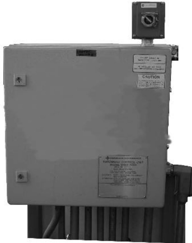
Fig. 11 Optional PowerLoad Remote Cabinet with W&M Keylock Switch / Optional cabinet à distance et interrupteur de P et M à clé.
