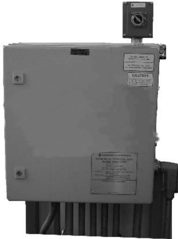
**Fig.11** Optional PowerLoad Remote Cabinet with W&M Keylock Switch/ Optional cabinet à distance et interrupteur de P et M à clé .
