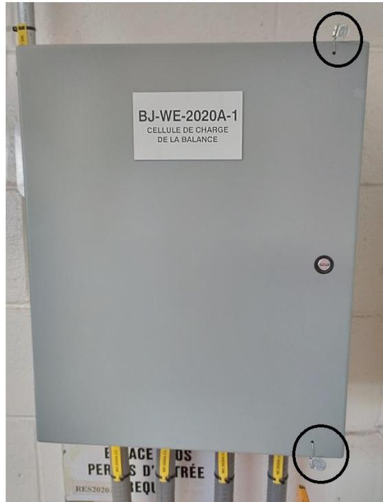
**Junction box sealing location / Location du scellage de la boîte à jonction****SECTION 9 - Evaluated by**
