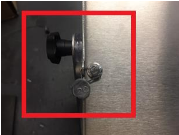
Typical Sealing for Stainless Steel Enclosure / Scellage typique pour boîtier en acier inoxydable
