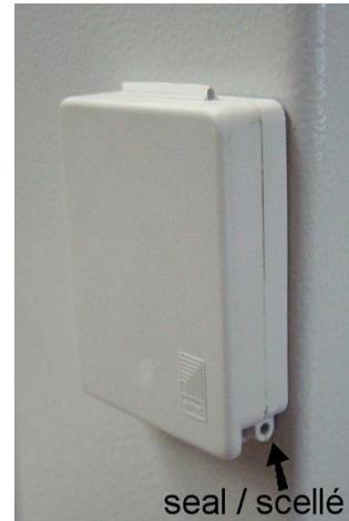
**Typical control cabinet sealing / Scellage typique du boîtier de l'unité de commande.**
