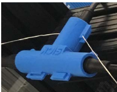
Typical cable sealing modules / Modules typiques de scellage des câbles
