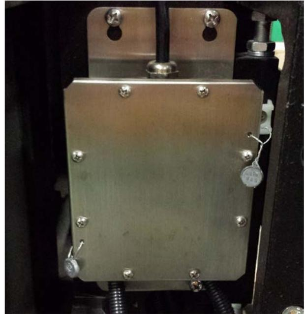
**Typical sealing of the junction box / Scellage typique de la boîte de jonction**
