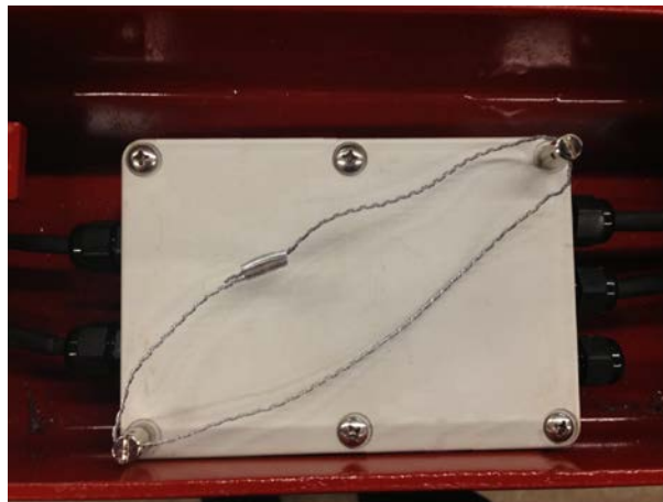
Junction box sealing / Scellage de la boîte de jonction
