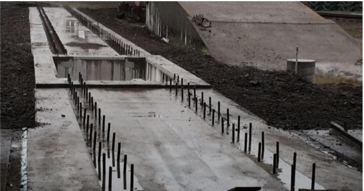
**Typical scale pit foundation and approaches / Fondation de la balance et les approches**
