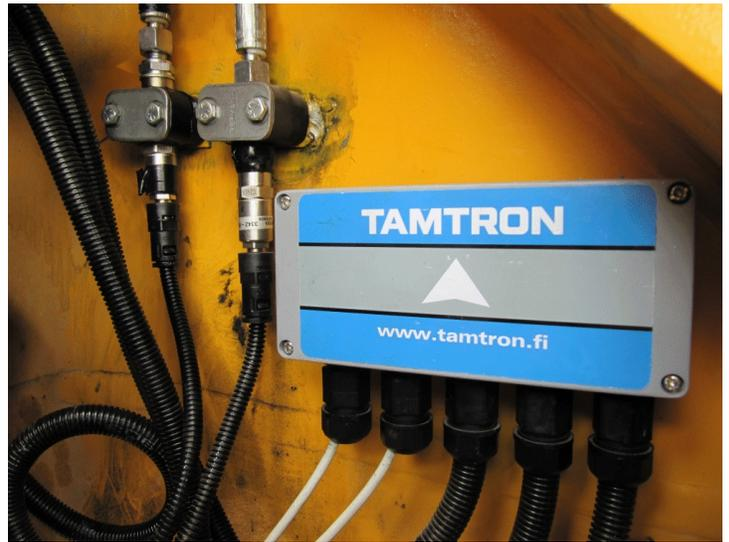
**Typical installation of pressure transducers and junction box / Installation typique du transducteurs de pression et du boîte de jonction**
