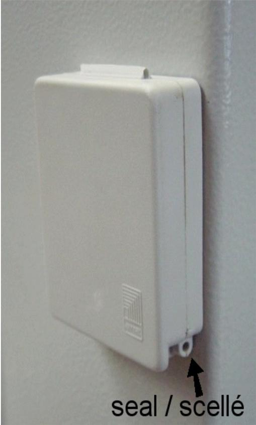
**Typical Cabinet Sealing / Scellage typique du boîtier de l'unité de commande**
