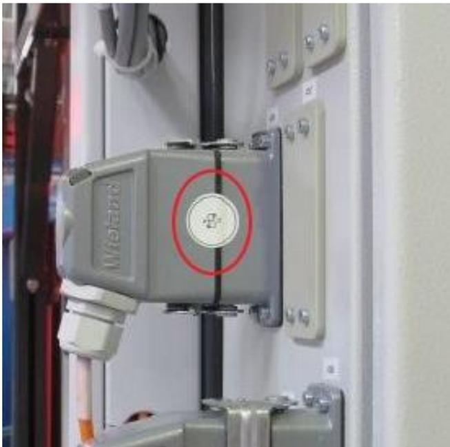
Computer cabinet connector sealing / Scellage du connecteur du boîtier de l'ordinateur
