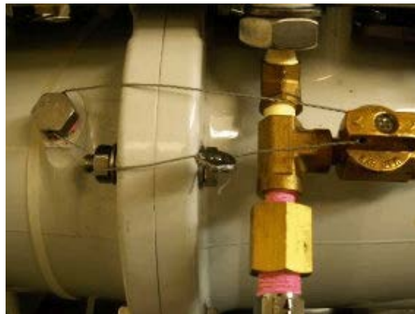
Figure 6. Sealing the temperature probe and the live pressure isolation valve / Scellage de la sonde de température et du robinet d'isolement de la pression de canalisation
