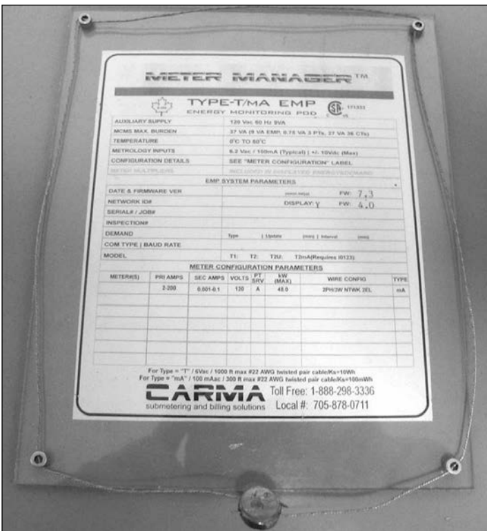
Outer Nameplate Seal / Scellage de la plaque signalétique extérieure
