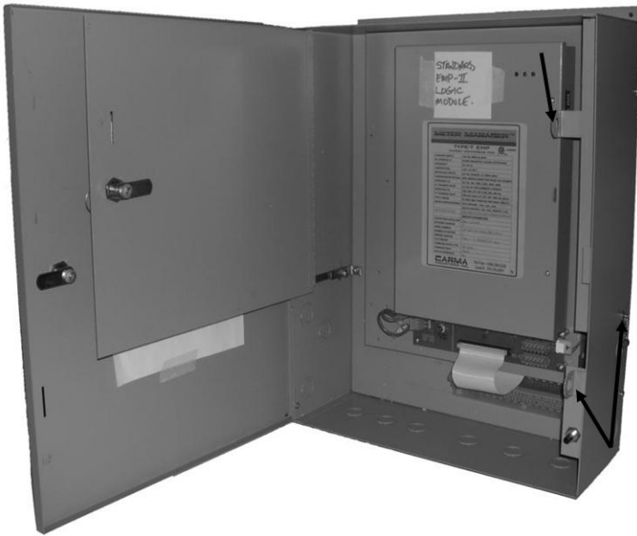
Model T1 enclosure with metrology seal (upper arrow) and utility seal (lower arrows) / Boîtier du modèle T1 avec un sceau métrologique (la flèche supérieure) et un sceau d'installation (les flèche inférieures).
