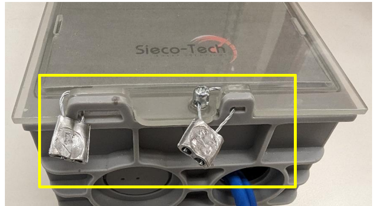
Door panel utility seals. / Joints d'étanchéité des panneaux de porte.
