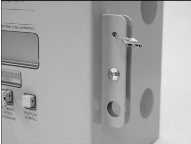
Installation Seal on RSM5c / Sceau d'installation sur le RSM5c
