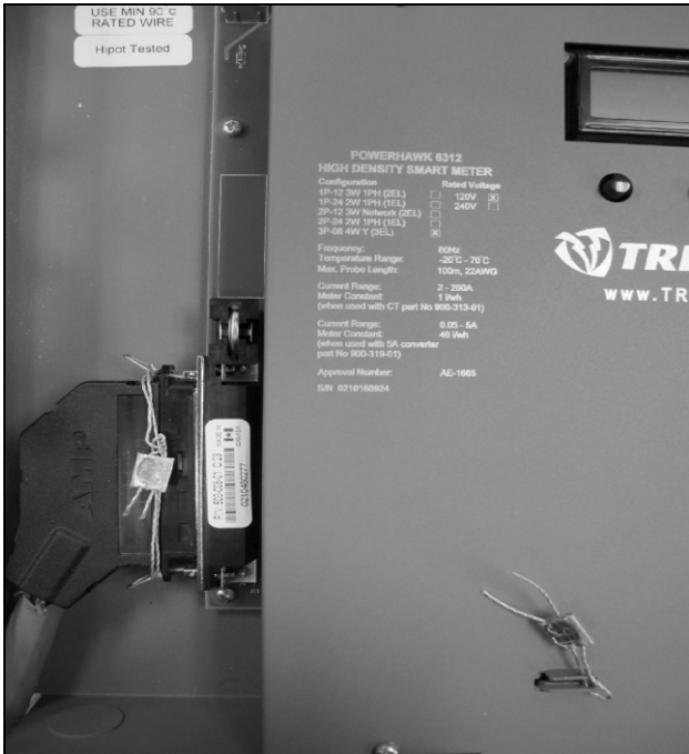
(1) Metrological Sealing Locations / (1) Emplacements des sceaux métrologiques
