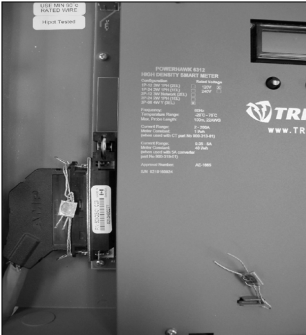
(1) Metrological Sealing Locations / (1) Emplacements des sceaux métrologiques
