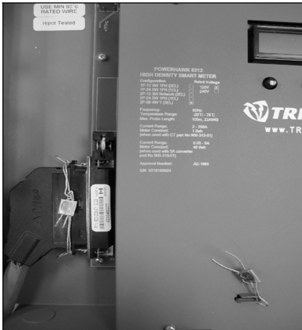
(1) Metrological Sealing Locations / (1) Emplacements des sceaux métrologiques
