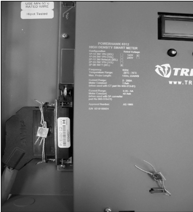
(1) Metrological Sealing Locations / (1) Emplacements des sceaux métrologiques
