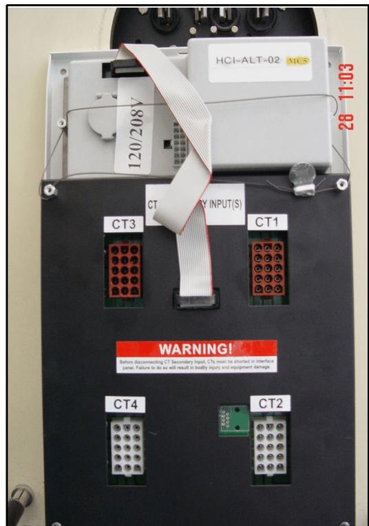
**Sealed head unit with CT inputs / Scelage de l'unité principal et entrée des TC**
