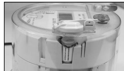
Battery Hatch / La trappe de la pile
